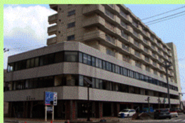
市営釜石ビル (3階まで床上浸水。4階以上は被害なし)
