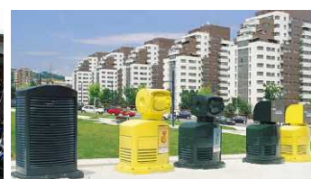
真空集塵システム挿入口のデザイン(ビルバオ・著者撮影)
