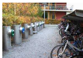
団地共有スペースにおける真空集塵システムの挿入口
